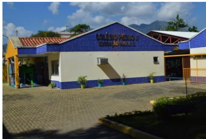
Figura 3: Fachada do CREIR (Fonte: PPP, 2017, capa)
